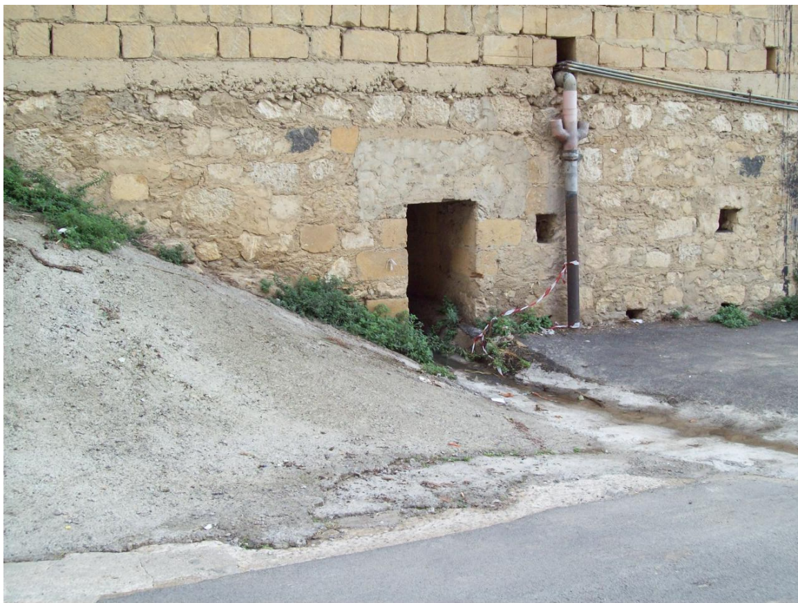
Punto d' uscita della condotta di scarico su via Catanzaro sottostante fabbricati residenziali
